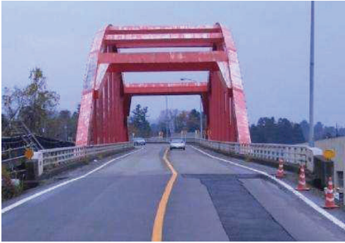
Longitudinal linear misalignment
